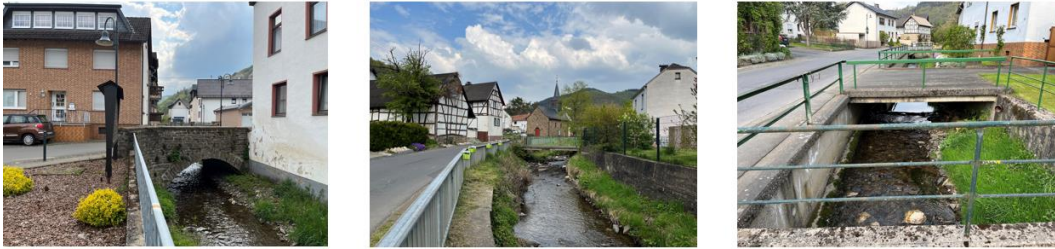
Abbildung 26: verschiedene Kesselingener Brücken
